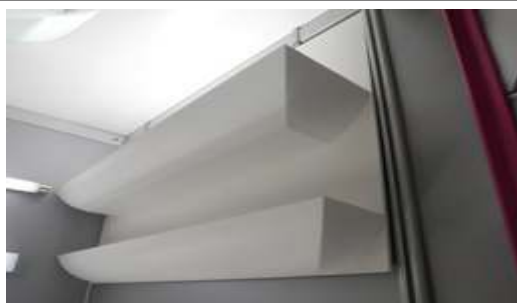
Epäsuora valaistus. Valo heijastuu seinän ja katon kautta häikäisemättä. Ylinnä WT4-lista, sen alla kapeampi WT3-lista.
