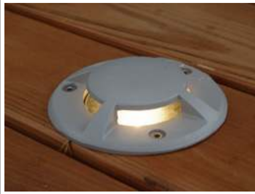
Talo 34. Kompastumisvaara. Poista nämä lattiaan upotetut valaisimet, ennen kuin joku lapsi kompastuu niihin. Juuri nämä poistettiin kaikki esim. Turun kävelykadulta.
