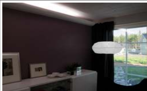
Keittiön valaistus on epäsuora. Häikäisyä ei ole, nähdään erinomaisesti. Valaisimina 49:n ja 54 W:n Viva-Lite-IP64-Saalinki-rakennussarjat.
