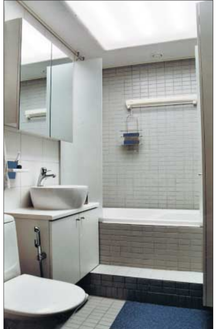
Kylpyhuone. Valokatto opaaliakryylistä. Valaisimina Saalinki-valaisimet. Riittävä ja kaunis valaistus. Erillistä peilivaloa ei tarvita.
