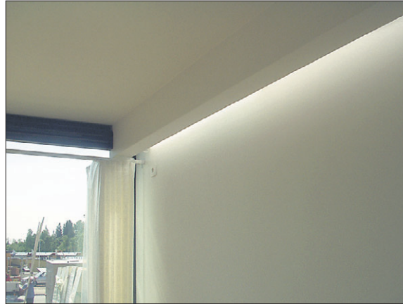
Epäsuora päivänvalovalaisuus on sävyllään hyvin samankaltaista kuin ulkovalo. Ei mitään häikäisyä, sisustuksen värit ovat aitoja.
